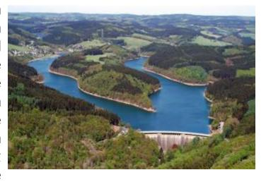
Staumauer ist bis zu 230m lang und 45m hoch. Der Bau hat 3 Jahre gedauert. Im Vergleich zu anderen Talsperren hebt sich die Aggertalsperre dadurch ab, dass sie aus drei Tälern besteht und nicht aus einem großen See. Primär wird die Talsperre zur Stromerzeugung genutzt. Die erzeugte Leistung beträgt bis
